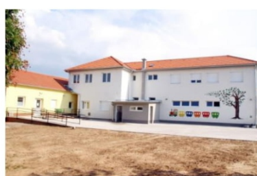
Óvoda felújítás és bővítés 90 millió ft EU-s pályázat megyei elbírálás
