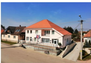
Egészségház felújítás: 29 millió ft Belügyminisztériumi határozat
